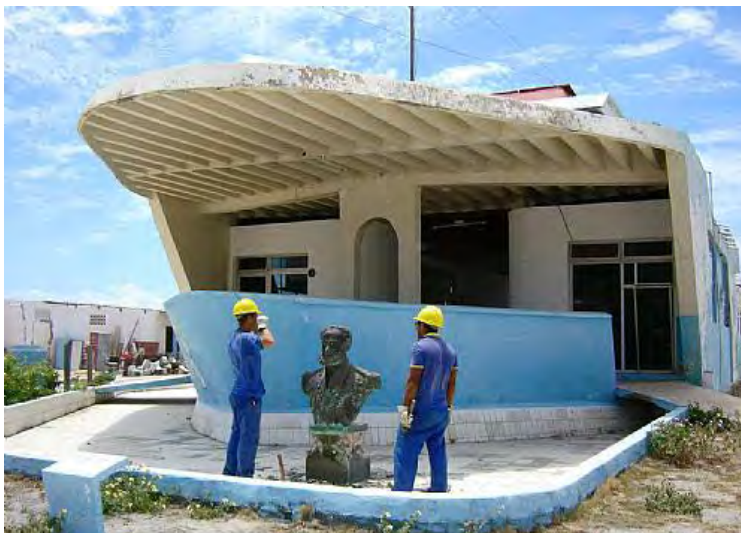
Imagem 16: Edifício em formato de iate durante sua demolição em 2006.
